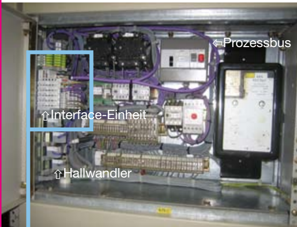
Einblick Schaltfeld mit Sensor-Modul
